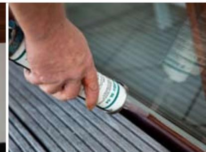
12:50 Uhr: Der letzte Schritt: Die Scheibe wird auf der Außen- und Innenseite mit Silikon versiegelt. Fertig!
